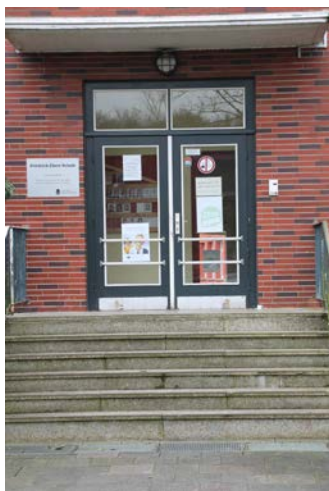
Alte Eingangstür in der Friedrich-Ebert-Schule Einfachverglasung Eisenrahmen
