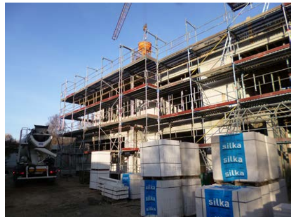
Rohbau Erweiterungsbau Schulzentrum Sophie Scholl
