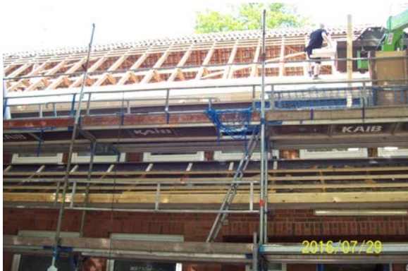
Dach der Jugendherberge Wüstewohldede vor dem Aufbringen der Wärmedämmung und der Dacheindeckung
