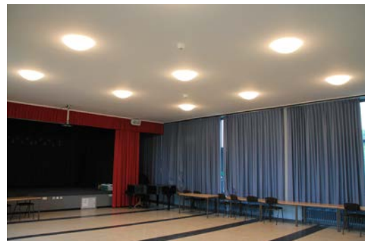
Neue Beleuchtung (LED) in der Aula der Goetheschule
