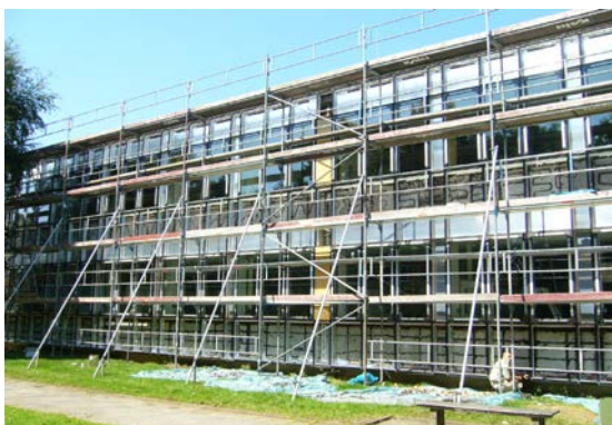
Demontage der alten Fassadenverkleidung und der Fenster in der BS DGG
