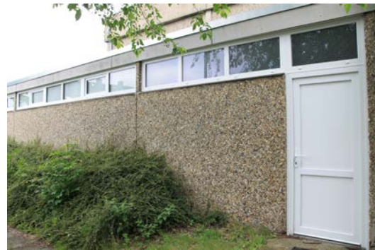
Neue Tür- und Fensteranlage Paula-Modersohn-Schule
