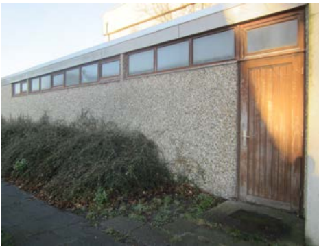
Alte Tür- und Fensteranlage Paula-Modersohn-Schule
