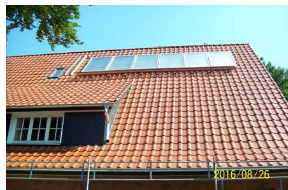
Neues wärmegeädmmtes Dach mit neuer solaren Brauchwassergewinnungsanlage der Jugendherberge Wüstewohldede
