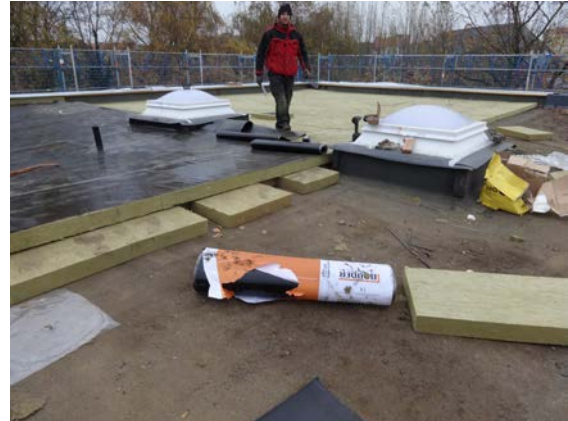
Neue Wärmedämmung auf dem Dach der Pestalozzischule
